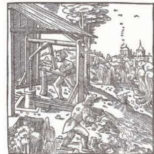
Die Stube A. Die Wille B. Die zwei Räder C. Die Kollben D. Der Handgriff E. Die Getriebe F. Die Arbeit der die zum Gerinne abfließend Wasser zu lenken, daß es nicht in die ausgehauenen Gruben fließt G.
